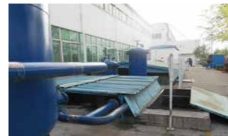
电火花加工液的过滤再循环使用
